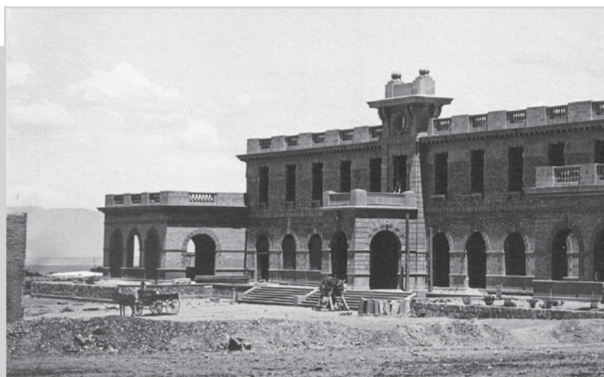
Construcción de la Estación Unión del Ferrocarril Saltillo-Tuxpan, 1919. Foto de Alejandro V. Carmona. Fototeca del Archivo Municipal de Saltillo.
